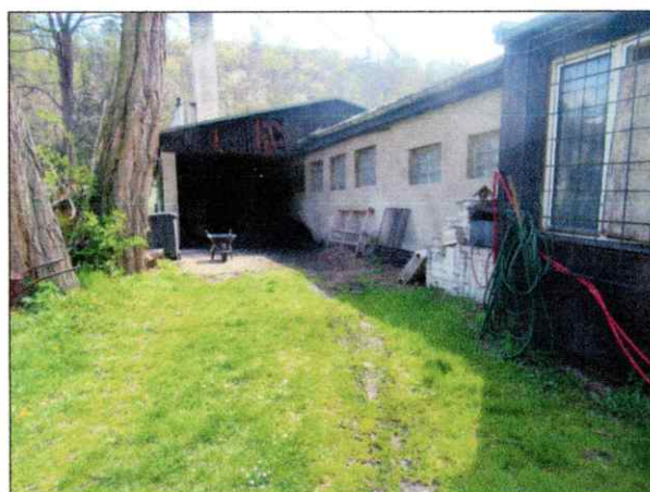
Stavba tvořící příslušenství – pohled ke kotelně
