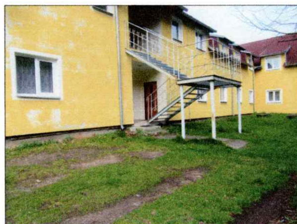
Ocelové požární schodiště
