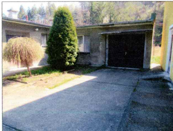
Stavba tvořící příslušenství – garáž a bývalý byt
